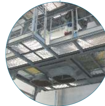
Goulotte de vidange du malaxeur vers le camion
