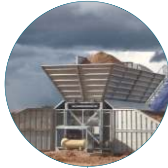
Panneaux de délimitation de la zone de chargement béton (benne ou camion)
